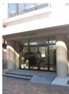
《ビル正面玄関》
