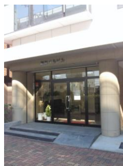
《ビル正面玄関》
