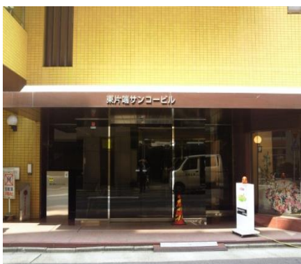
《ビル正面入口》
